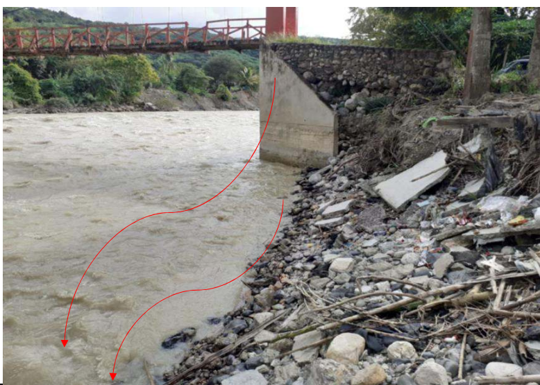
FIGURA N°01: TRAMO CRÍTICO EN EL CAUCE DEL RIO UTCUBAMBA, EN EL PUENTE EL SALAO PRESENTADO EROSION EN LA MARGEN IZQUIERDA DEL RIO EN EL SECTOR HUINGO, DISTRITO DE JAMALCA, PROVINCIA UTCUBAMBA - AMAZONAS
